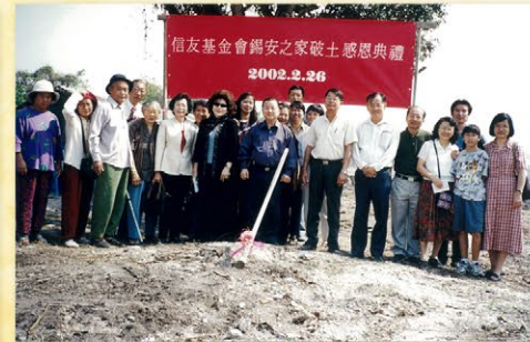
▲ 2002年錫安之家破土開工
